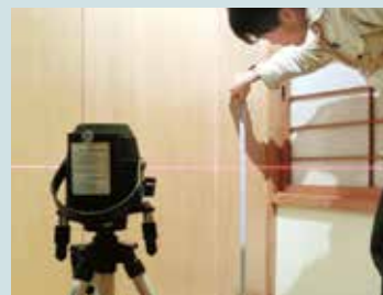
代表みずから、軒下や天井裏に入り、建物の診断をする。目視のほか、赤外線サーモグラフィやセンサーなどの機器も使用して診断を行うケースもある。
