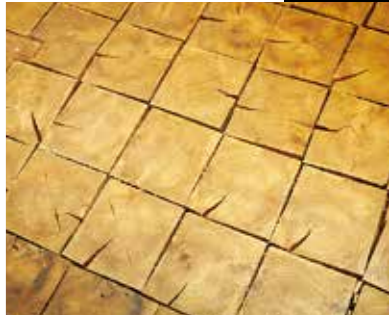
本社ショールームの床には、2.5センチの厚さにカットした秋田杉のタイルが敷き詰められている。丸太の芯の部分を利用した。
