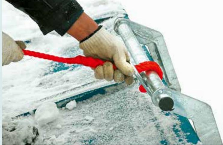
「命綱固定金具」は屋根に固定し、このように命綱(ロープ)を取り付けて作業をする。屋根の形状ごとに数種類を商品化する予定。
