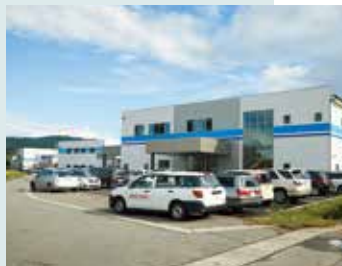
手前が7月に完成した新工場。奥に見えるのが既存の工場。事業を拡大してきた跡が刻まれている。
