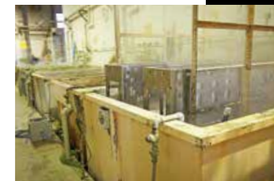
金属に塗装をほどこす前に、「アルカリ脱脂」「酸脱錆」「リン酸亜鉛被膜処理」「水洗」「湯洗」等の処理を行う。塗装の仕上がりを左右する大切な工程の一つ。
