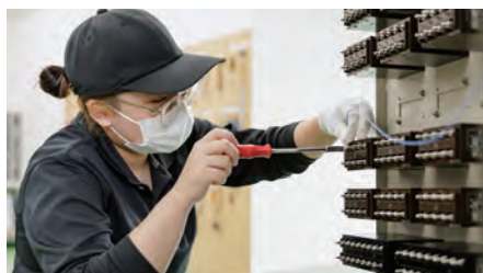
制御盤の組み立て作業を行う若手社員。 今回のプロジェクトにも参加している。
