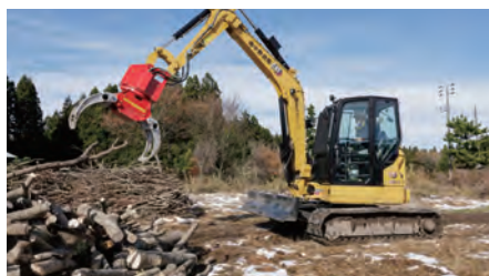
設備貸与制度を活用したバックホー。 切り落とした大きな木の幹などを移動するために使用している。
