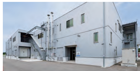
昨年8月に竣工した新社屋。 旧社屋は現在第2工場として活用するため、工事を行っている。
