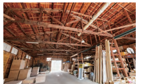
梁や筋交い以外にも、断熱材やサッシなども組み立てられたパネルを工場に製造。現場での作業が激減。
