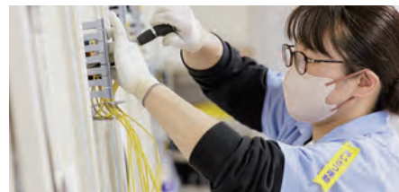
図面を読み解きながら、配電盤の製造を行う。
