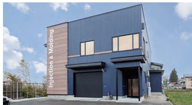
2026年に新しく建て替えた、秋田工場外観。
