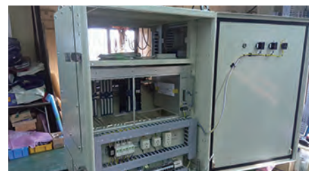
川崎支社に構える製造部門では制御盤や動力盤の製造を行っている。
