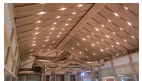
和の素材であり、不燃材という強みを持つ丸石銘木の部材。近年は防火に対する基準も高く、神社仏閣での需要も増えている。
