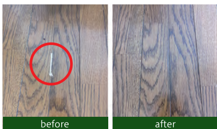
フローリングの傷はパテで補修し、色を合わせて木目を描く。どこに傷があったのか全くわからないほどに仕上がる。
