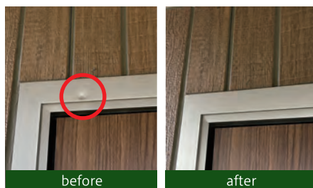
木材部分だけでなく、アルミも補修することが可能。全部交換せずにもるで新品のように蘇る。
