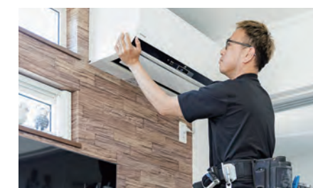
前職のころに取得した資格を活かし、 エアコンの取付作業も対応している。
